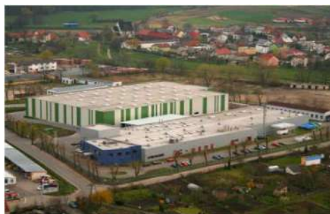
Rys. 1. Fabryka Armacell Polska w Środzie Śląskiej.
